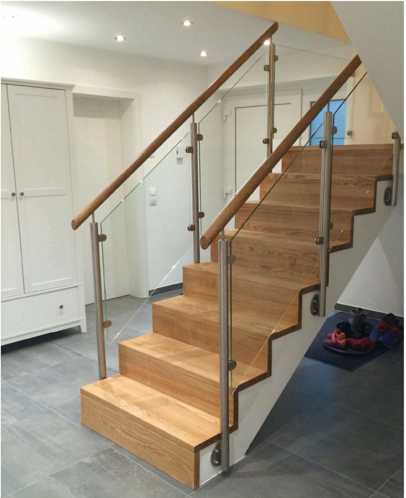
*Glasgeländer* und *Eichestufen* auf Betontreppe in Faltwerkoptik
